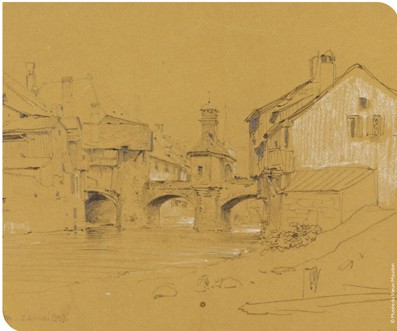
Vue du pont Saint-Eloi avant la démolition de sa chapelle. Ce dessin a été exécuté le 24 mai 1833 par Théodore Gudin, peintre officiel de la marine française.
