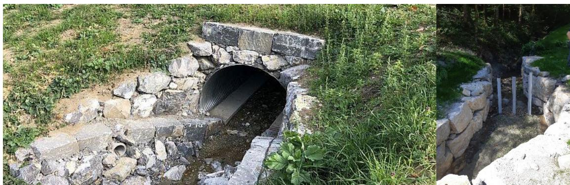
Figure 2 Pour exemple, illustration d'un tuyau et d'une herse
